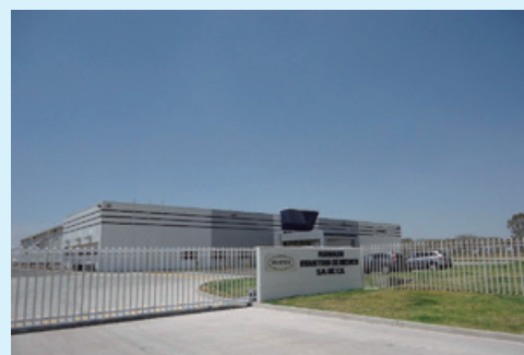
▲ASHIMORI INDUSTRIA de MEXICO, S.A. de C.V.外観 (現在の工場)
