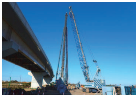
パレスシートの上で作業する大型クレーン
