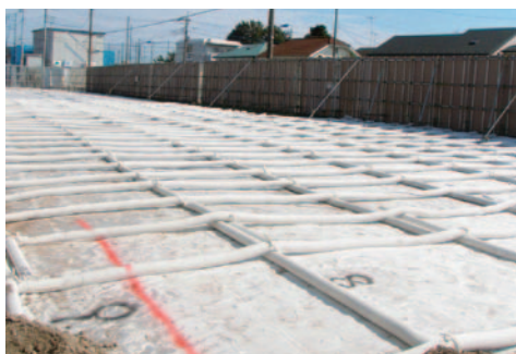
農用地に施工しているパレスシート
