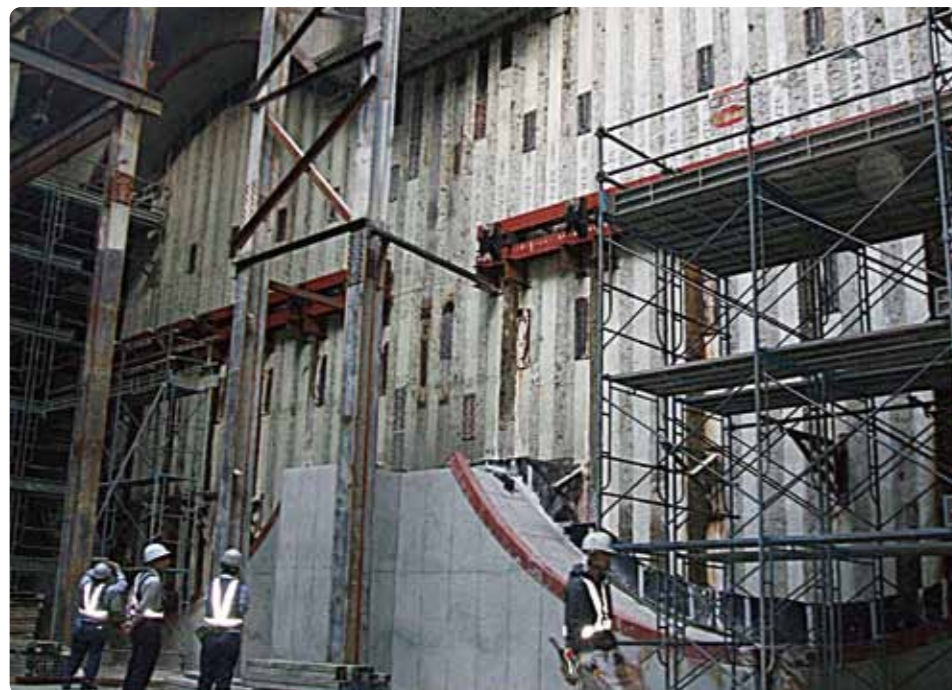
柱列式土留壁 (高速道路φ12,470)
