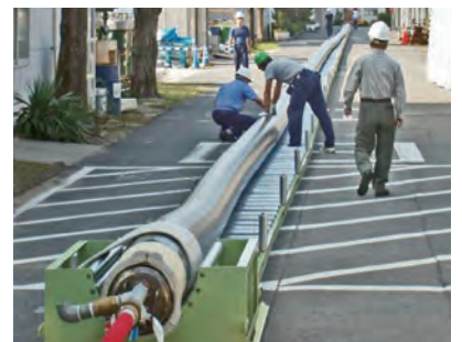
耐圧試験実施の様子
