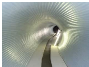
パルテム・フローリング工法
