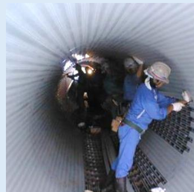
パルテム・フローリング工法
