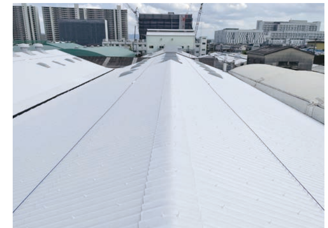
本社・大阪工場 屋根への遮熱塗装
