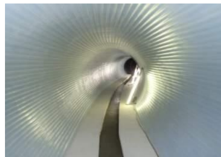
パルテム・フローリング工法 (管路更生工法)
