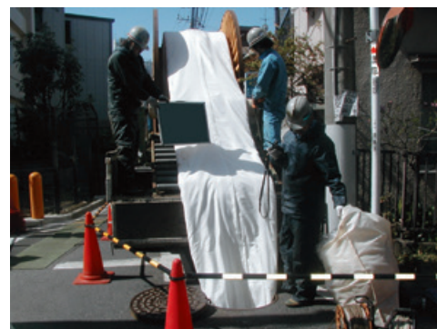
▲パルテムSZ工法
