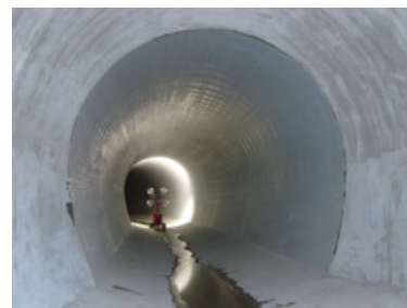
▲パルテム・フローリング工法
