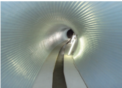
▲パルテム・フローリング工法
