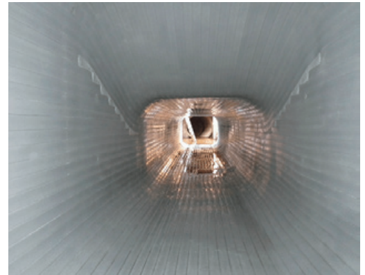
▲パルテム・フローリング工法
