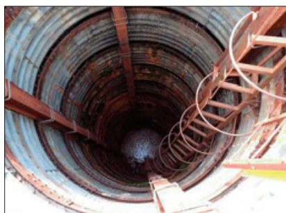
施工前の 集水井
