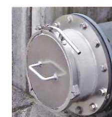
フランジフェルールと閉止フェールの併用例
