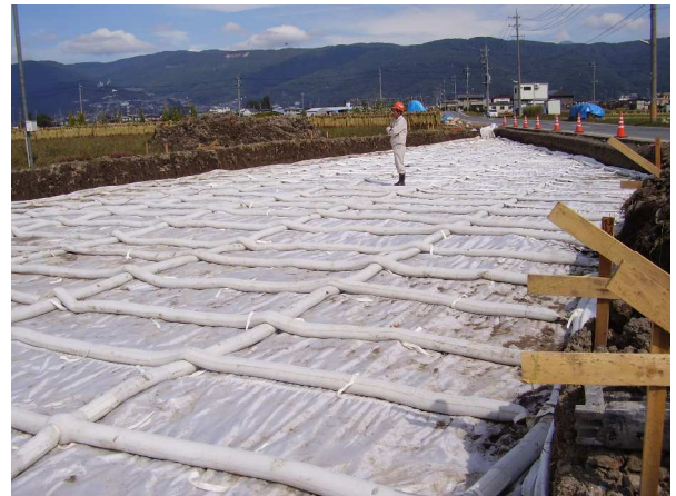
モルタル注入後のパレスシート
