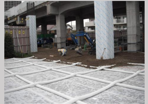
重機足場の地盤改良
