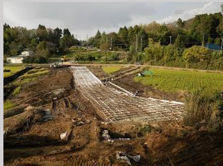
仮設工事用道路の地盤改良
