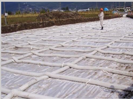
水田上の仮設道路の地盤改良
