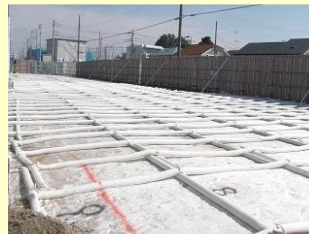
パレスシートによる地盤改良
