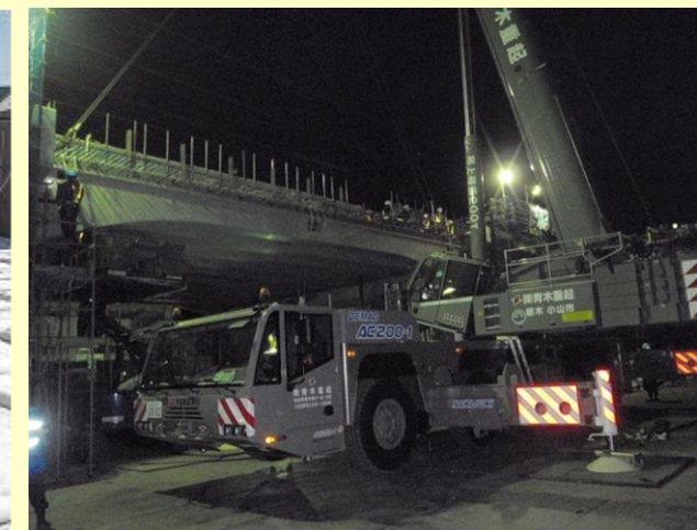
改良後の重機作業
