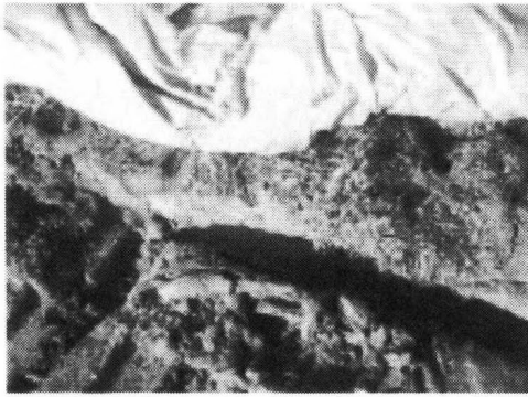
写真-8 パレスシート撤去後の地盤
