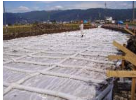
写真-1 施工状況
