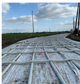
(b)モルタル充填完了
