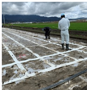
写真-1.(a)敷設状況
