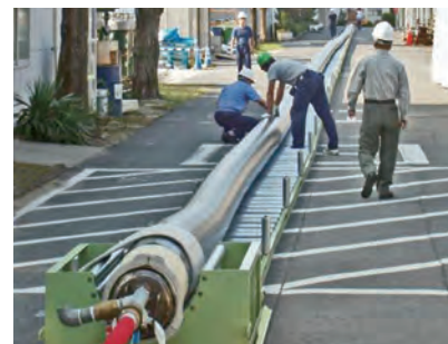
耐圧試験実施の様子
