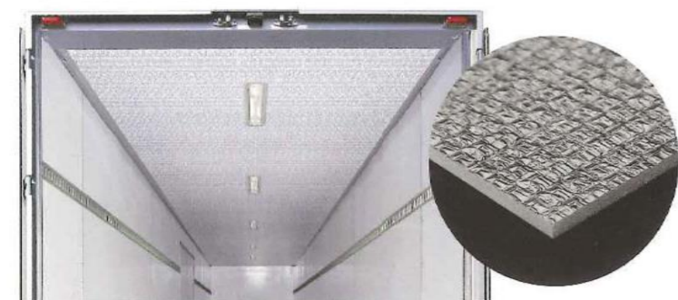
写真は結露防止シート施工姿
