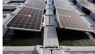
水上太陽光発電設備を接続固定するベルト類を提供し、クリーンエネルギーを支えます。
