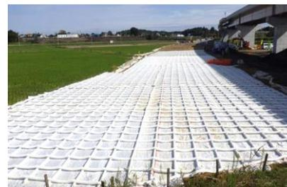
格子状補強枠（専用モルタル充填円筒織物）と補強枠下の土木シートにより荷重を分散させ、軟弱地盤での沈下を防ぐ表層処理工法です。撤去も容易で原状復帰が可能です。
