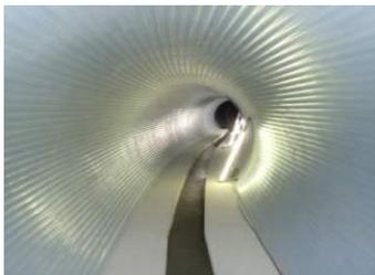
住宅リビングの床をイメージできるフローリング工法は、円形のみならずあらゆる断面形に対応できる、主に下水道向け管路更生工法です。
