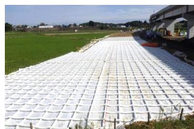
格子状補強枠（専用モルタル充填円筒織物）と補強枠下の土木シートにより荷重を分散させ、軟弱地盤での沈下を防ぐ表層処理工法です。撤去も容易で原状復帰が可能です。
